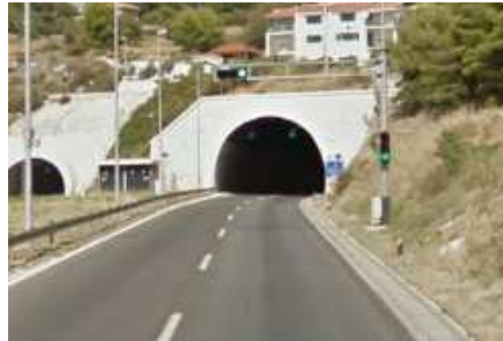
Slika 1. Efekt crne rupe (tunel Mravince)
