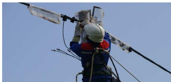
Slika 4. Spajanje SKS priključka na SKS mrežu
