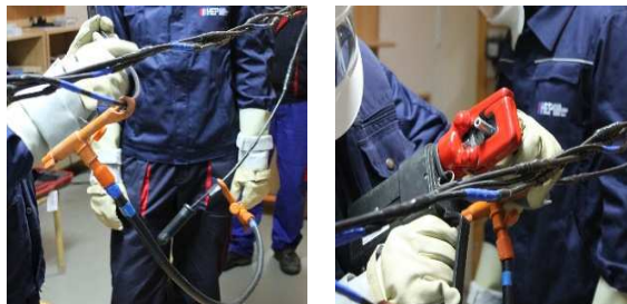
Slika 5. Primjer popravljanja jednog vodiča SKS- kabela
